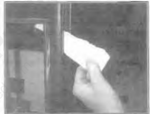
Checking Door Gasket
